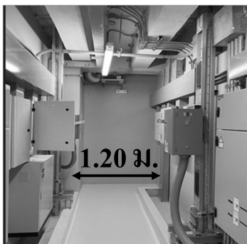
กรณีที่ 3 : ส่วนที่มีไฟฟ้าอยู่ทั้ง 2 ด้าน ของที่ว่าง 151- 600 V
