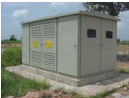
รูปที่ 7.4 ตัวอย่างการติดตั้งหม้อแปลงในเครื่องห่อหุ้ม
