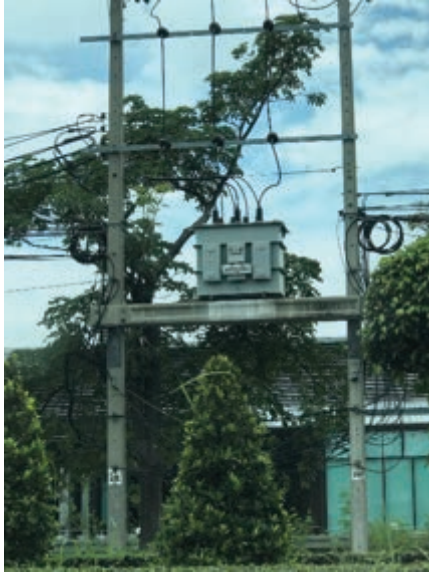
รูปที่ 7.3 หม้อแปลงการติดตั้งหม้อแปลงบนนั่งร้าน
