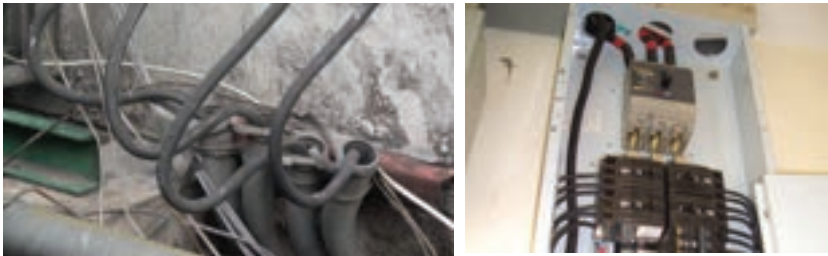
รูปที่ 3.4 การเดินสายที่เกิดความร้อนจากกระแสเหนี่ยวนำ (ตัวอย่างที่ผิด)
